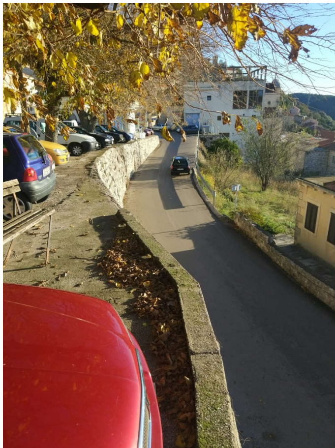
Slika 8. Pogled s platoa na potporni zid
