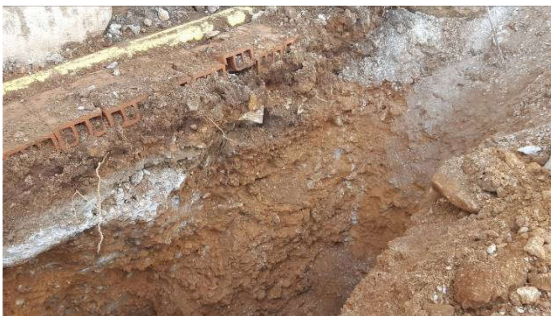
Slika 13. Iskopani rov na zapadnom dijelu parcele, cca 25 m od početka predmetnog potpornog zida
