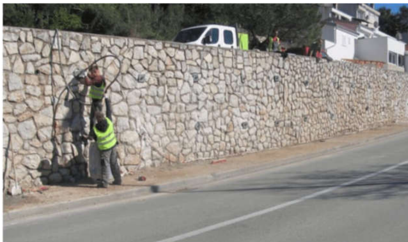
Slika 29. Primjer kamenog potpornog zida saniranog sidrima
