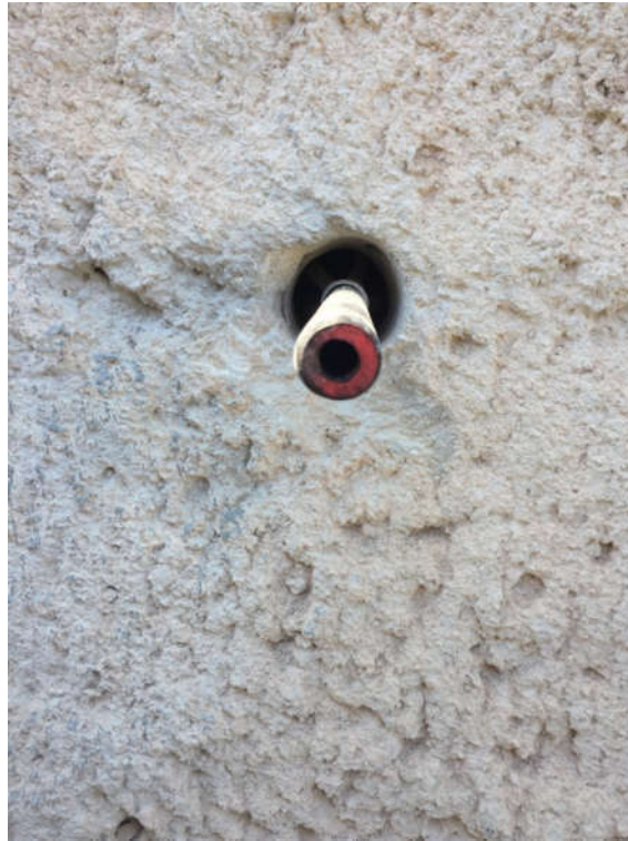
Slika 28. Primjer ugrađenog samobušivog sidra
